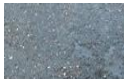
Pavimentazione in rasoconcrete
